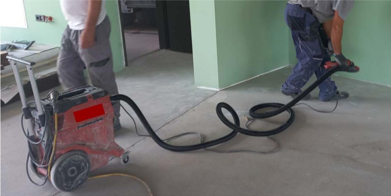
Auf dem Foto verwendet die Person rechts im Bild ebenfalls eine abgesaugte Handmaschine, links im Bild befindet sich der Bausauger, über den die Staubabsaugung gewährleistet wird.
