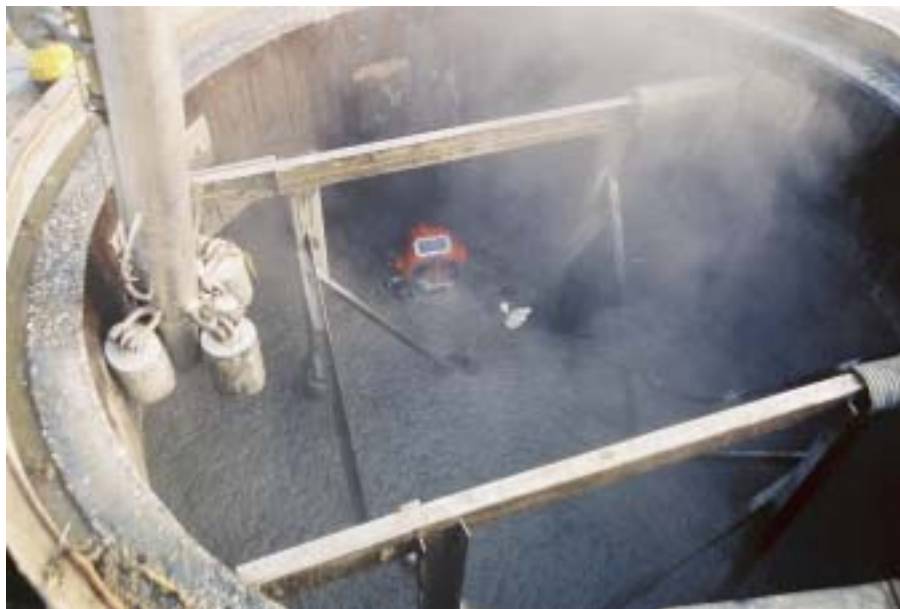
Tauchereinsatz bei der Faulturmreinigung
