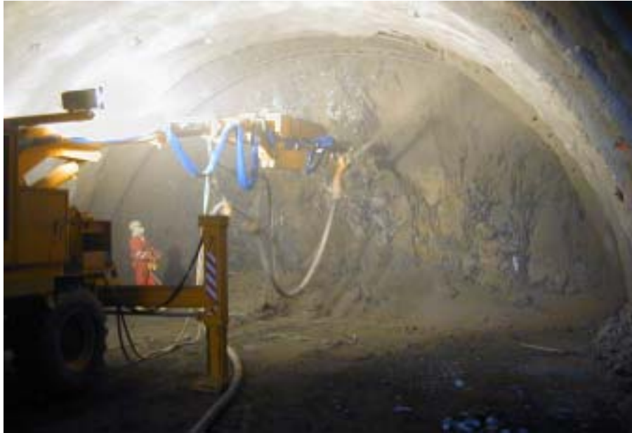
Einsatz von Manipulatoren beim Nassspritzverfahren
