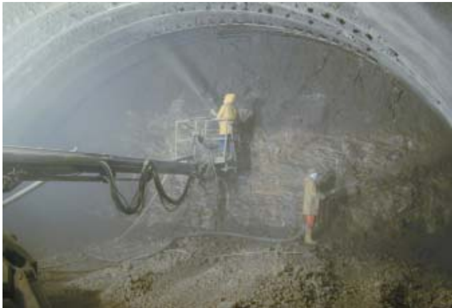
Düsenführer beim Trockenverfahren
