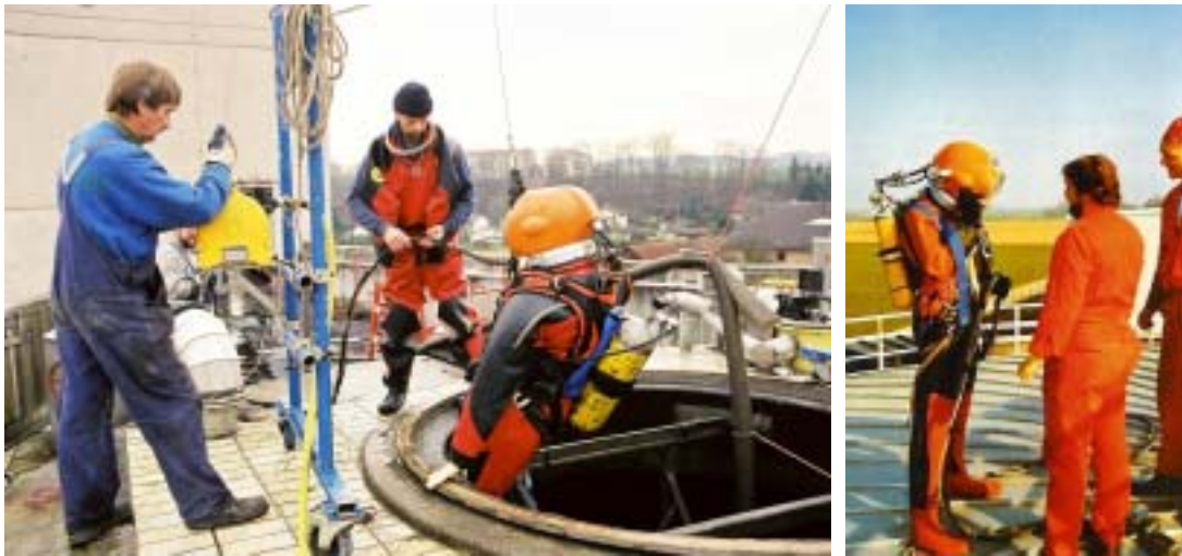
Mannschaft zum Reinigen der Faultürme
