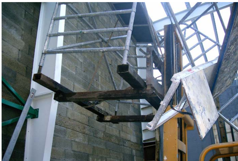
Hubstapler mit „Hilfskonstruktion“
