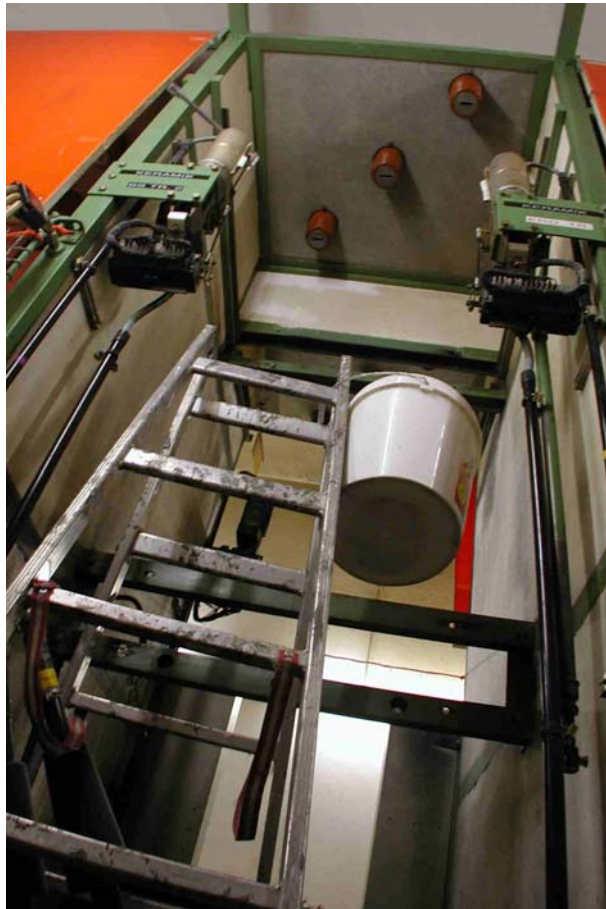
Reinigungs- und Malerarbeiten an der Zellenabschottung
