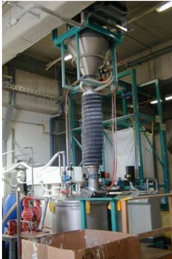
Automatische Dosierstation mit Wiegeeinrichtung und Sackstation
