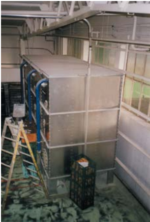
Mehrsilo mit Filtertuchabschluss
